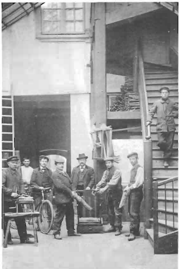
COUR VITRÉE — ATELIER — ESCALIER DU DORTOIR
