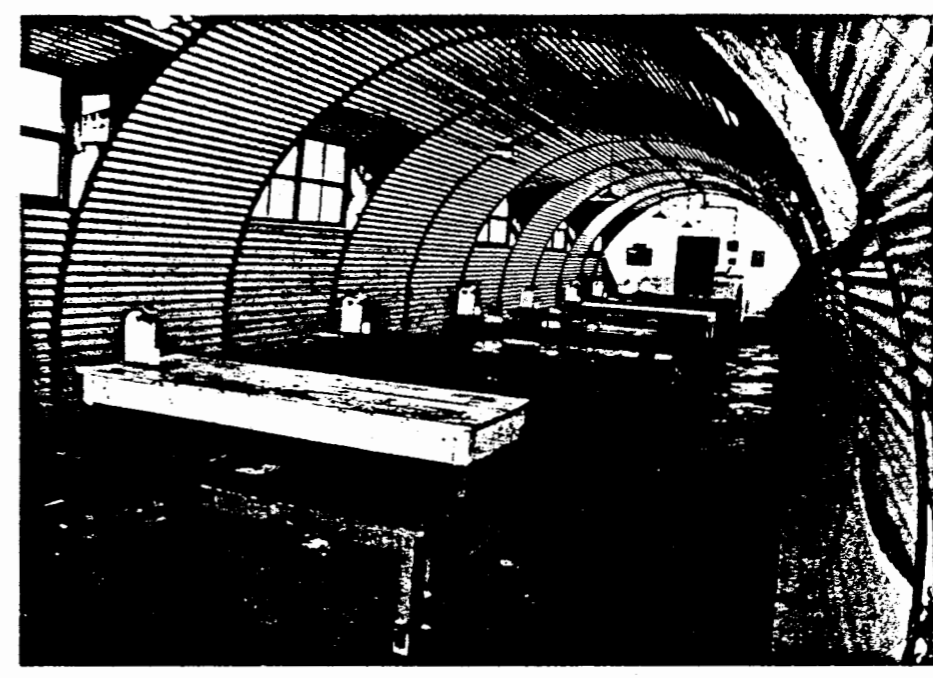
Avant la restauration des locaux
