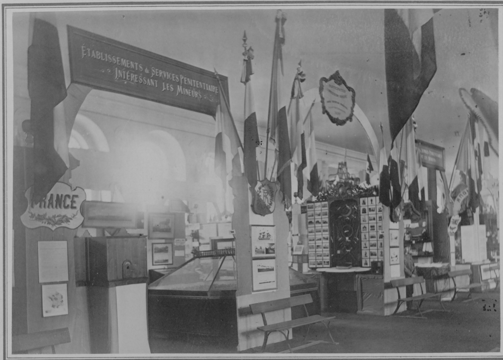
Colonies agricoles et industrielles. — (Travaux de jeunes gens).
