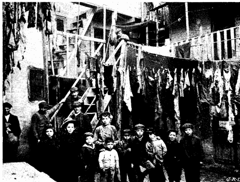
FIG. 6. — Cour d'une habitation au quartier espagnol à Marseille.
