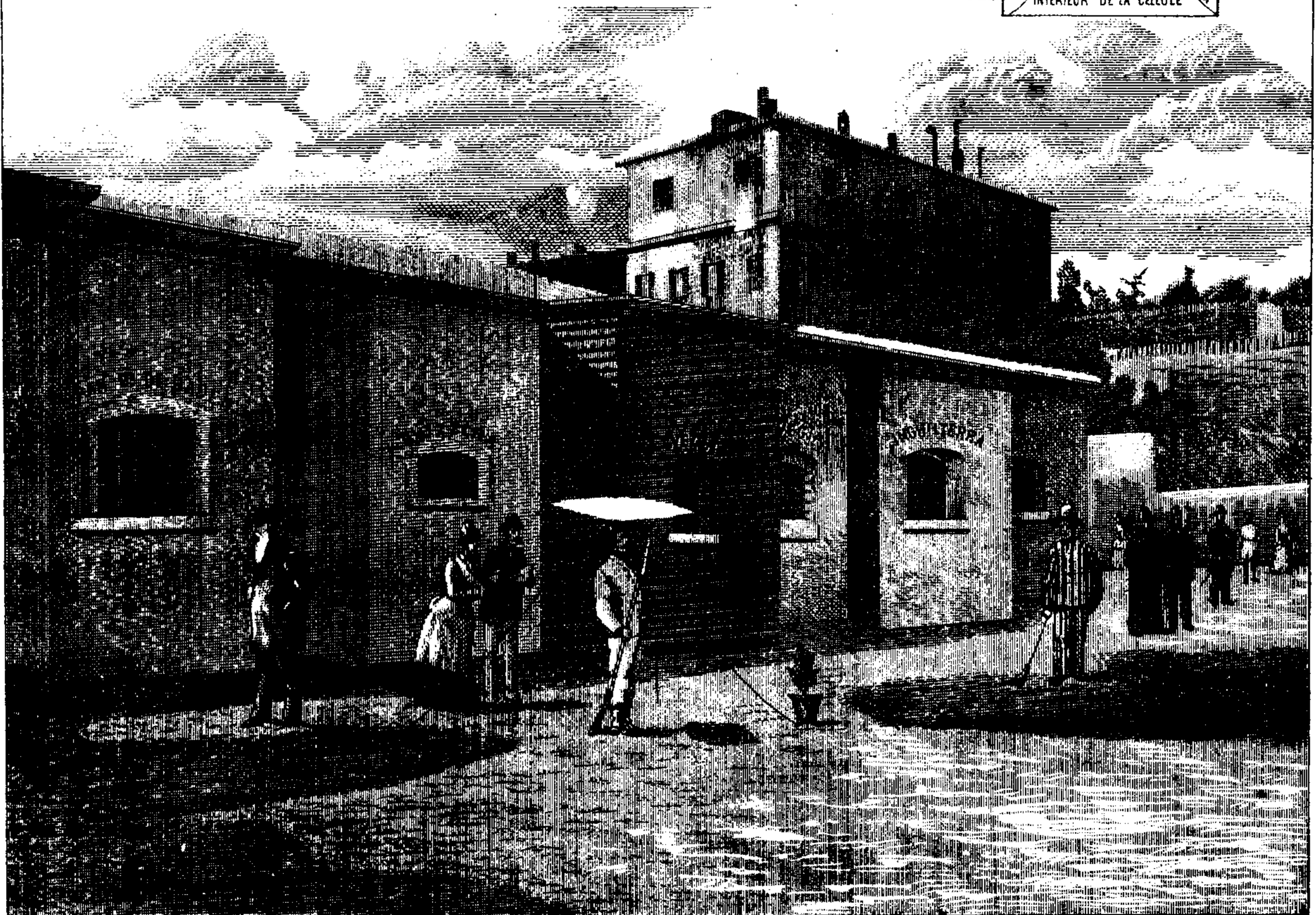
VUE EXTÉRIEURE DES CELLULES
