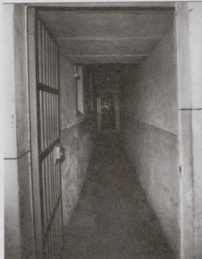
MA Épinal - Couloir
